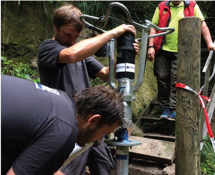
Elektrischer Einbau der Schraubfundamente beim Treppenabstieg
