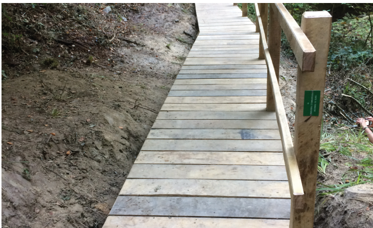
Fertig erstellt Holz-Passarelle mit Handlauf
