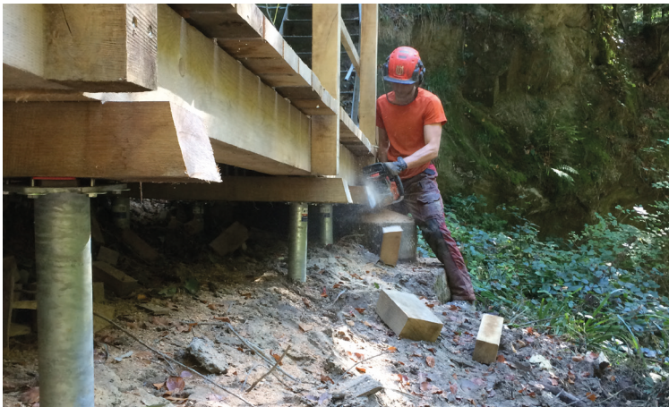
Die Holzunterkonstruktion ist mit den Schraubfundamenten verschraubt.
