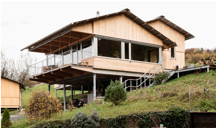
Einfamilienhaus nach Fertigstellung
